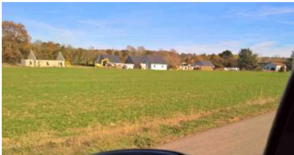
Vue sur le lotissement en cours de construction
